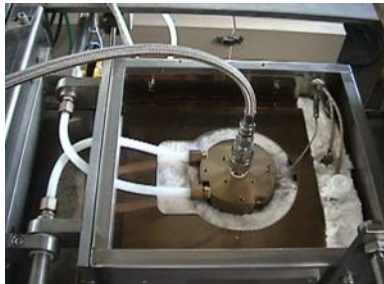
スプリンクラー取付マウント部
